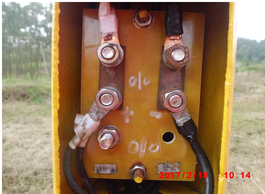
去耦合器排流测试桩接线图
